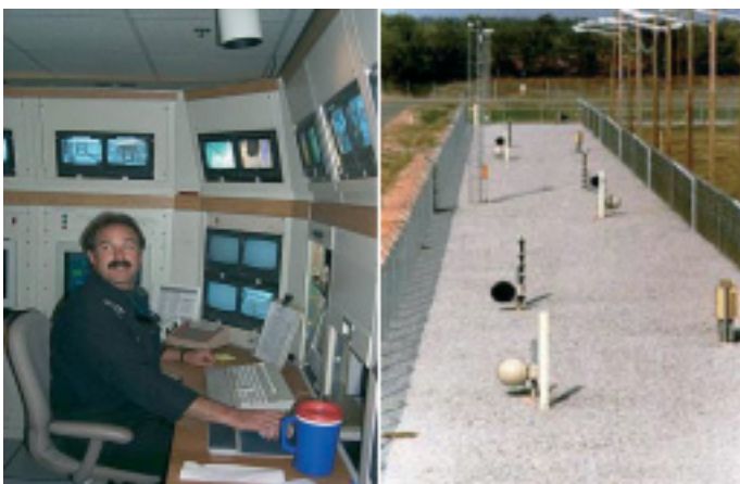
Пультовая и контрольно-следовая полоса объекта
